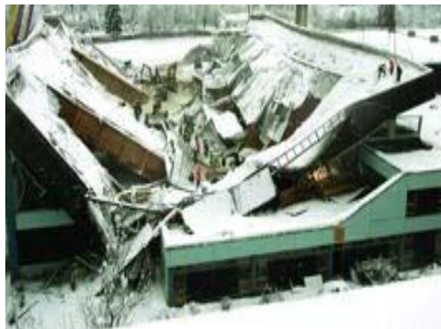
Fig. 24 – Colapso de Uma Estrutura devido à Neve
