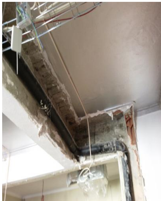
Fig. 66 – Demolição das Sancas que Ocultavam a Rede de Drenagem Existente (Piso 1)
