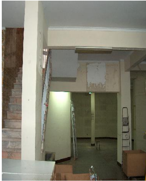
Fig. 63 – Existente Interior (Piso -1)
