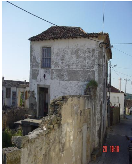
Fig. 4 – Edifício Principal (Vista Sul)
