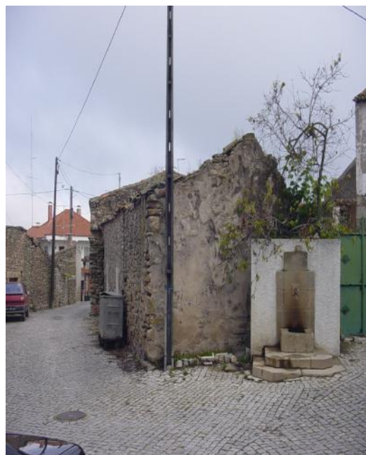
Fig. 5 – Edifício para Arrumos e Garagem
