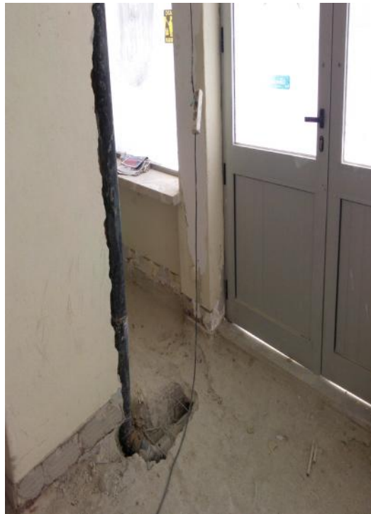
Fig. 67 – Demolição (retirado o pavimento e a betonilha de regularização) (Piso 0)
