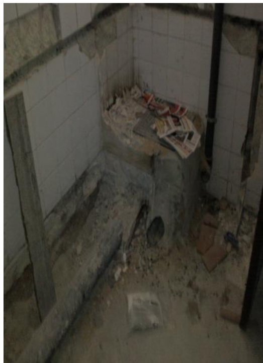
Fig. 68 – Caixa de Visita da Rede de Esgotos (Piso -1)
