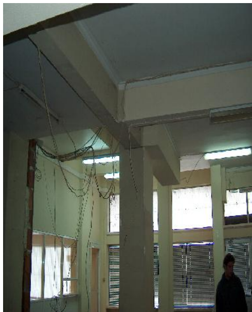
Fig. 64 – Existente Interior (Piso 0)
