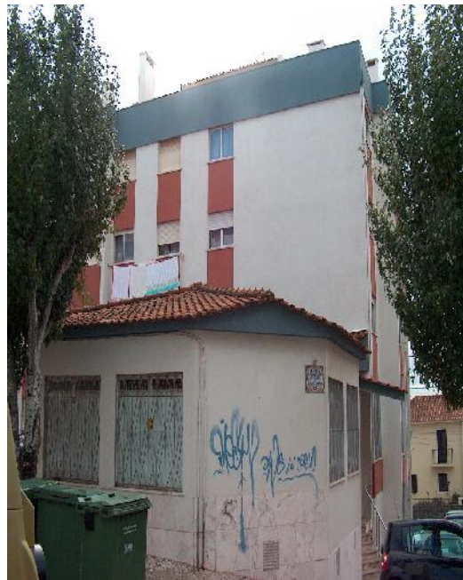
Fig. 65 – Existente Exterior (Piso 1)
