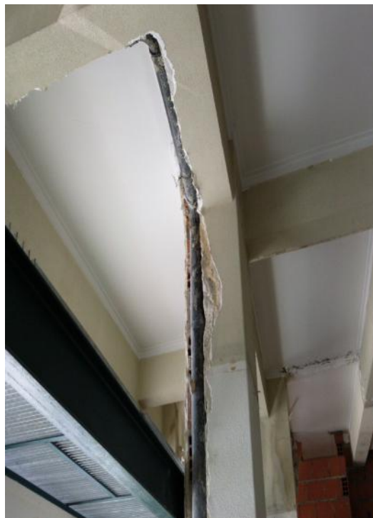
Fig. 72 – Piso Técnico do AVAC (Piso 0)
