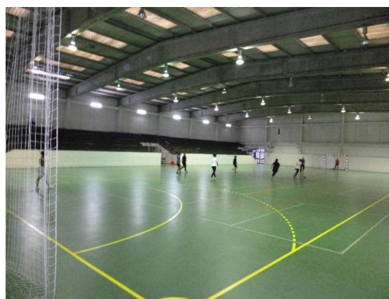
Imagem 12- Vista interior do pavilhão municipal (fonte estagiário)
