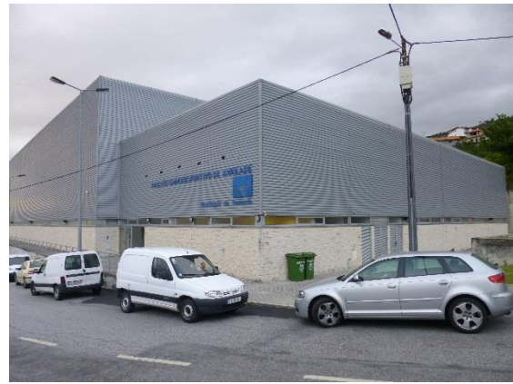
Imagem 21- Vista exterior do pavilhão gimnodesportivo de Anreade (fonte estagiário)
