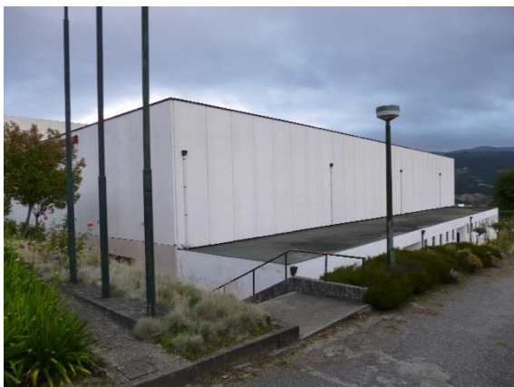
Imagem 11- Vista exterior do pavilhão municipal (fonte estagiário)
