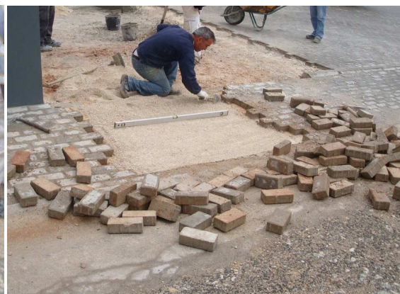
Figura 11 – Pavimentação do passeio
