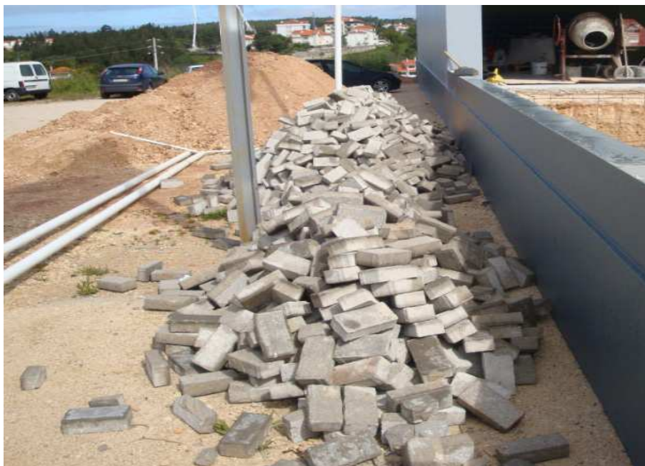
Figura 5 – Blocos e terra removidos do pavimento
