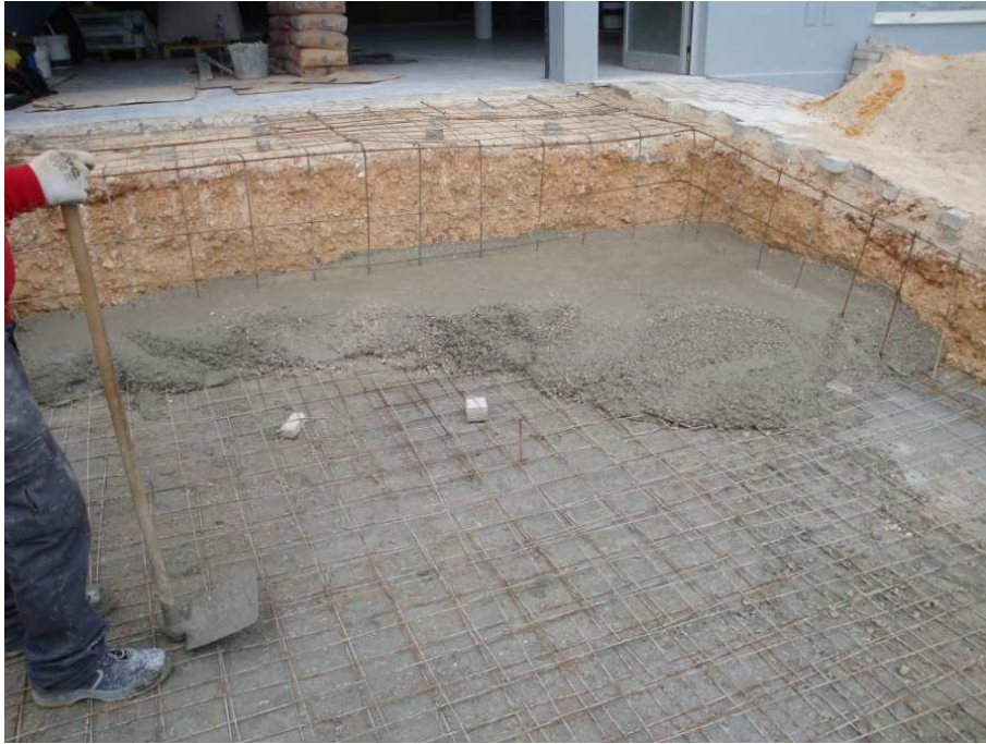
Figura 7 – Betonagem da laje térrea
