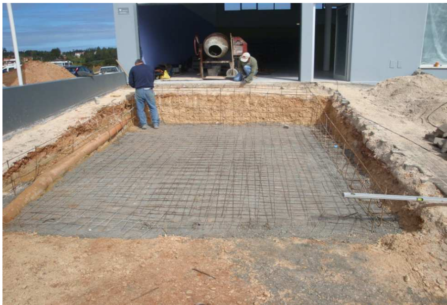
Figura 6 – Betão de limpeza e arranque das armaduras
