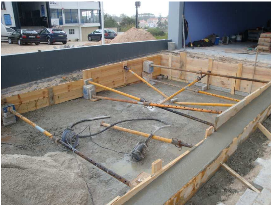
Figura 8 – Cofragem, escoramento e betonagem dos muros
