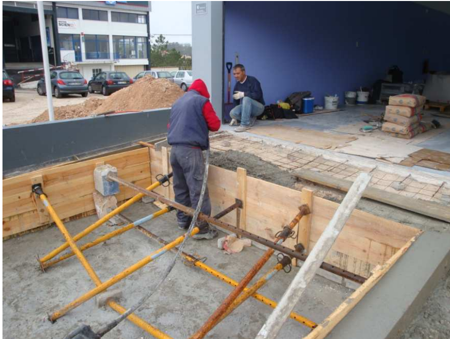
Figura 9 – Betonagem da laje de entrada
