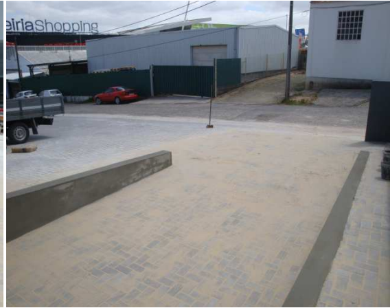
Figura 13 – Preenchimento das juntas
