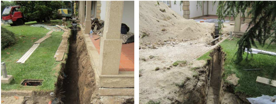
Figuras 16 e 17 – Abertura de valas
