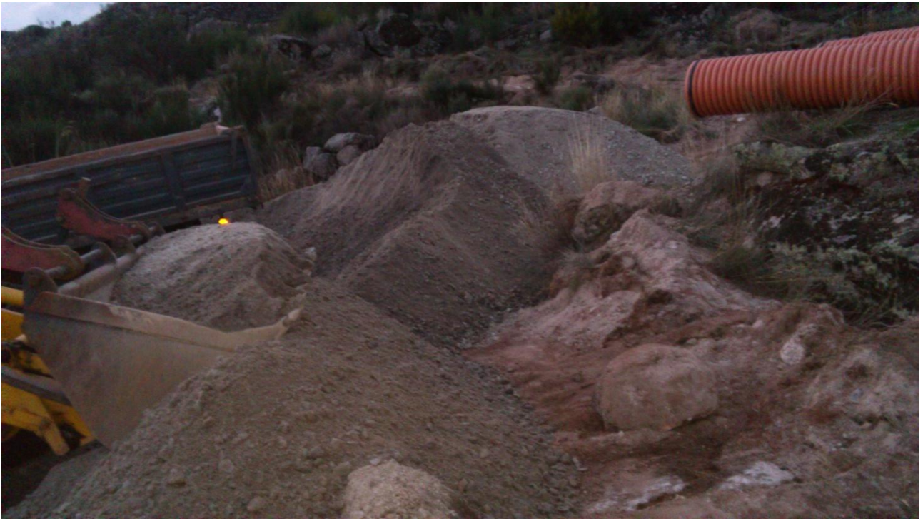
Figura 21 - Material a aplicar - toutvenant
