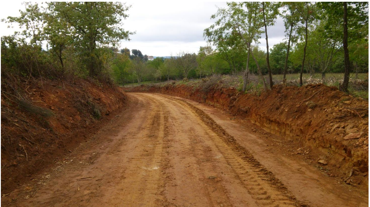
Figura 20 - Regularização do fundo da caixa
