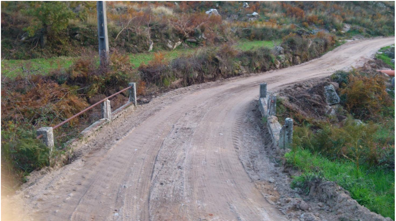
Figura 15 -Inicio dos trabalhos, regularização da caixa de estrada
