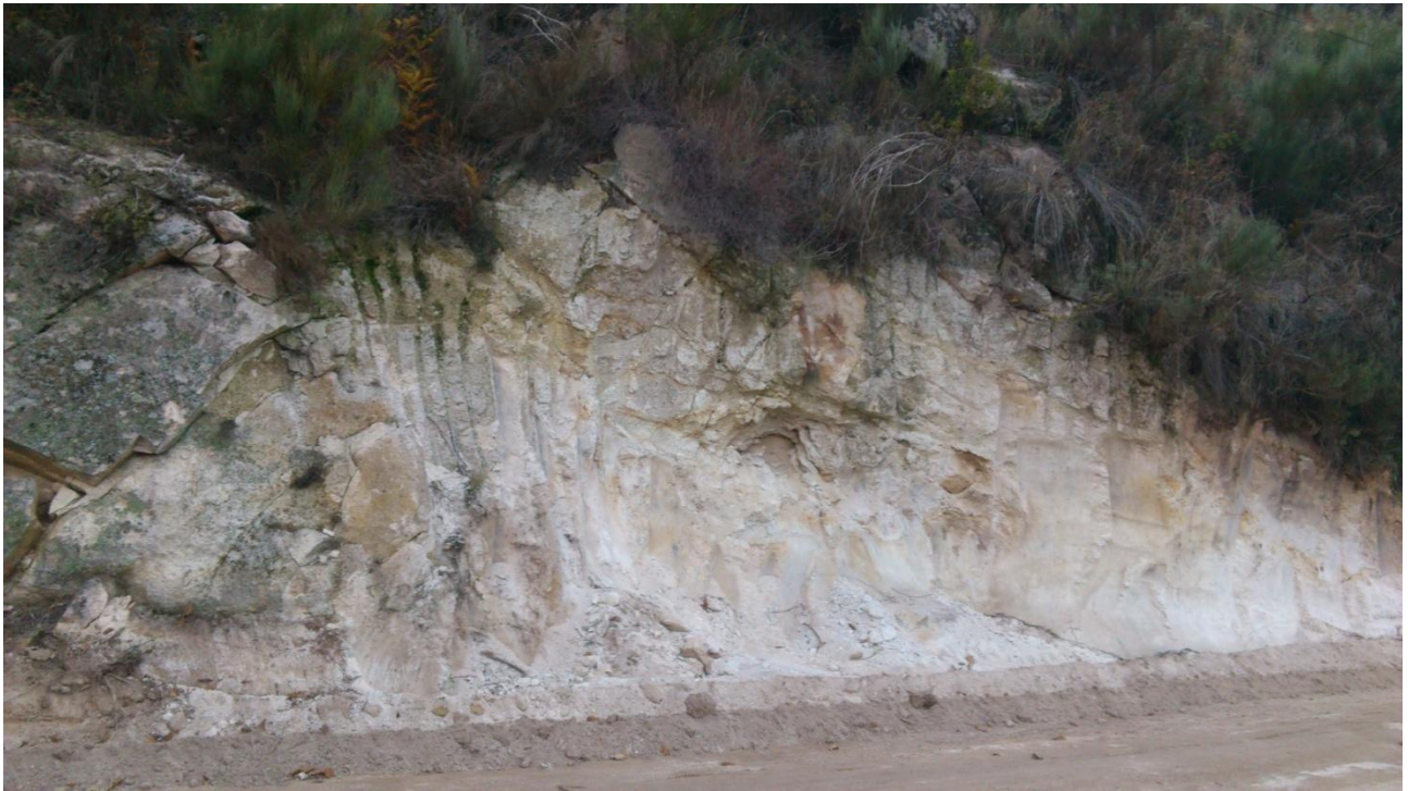
Figura 16 - demolição e elementos necessários à realização da obra, tais como demolição ou desmonte de rocha
