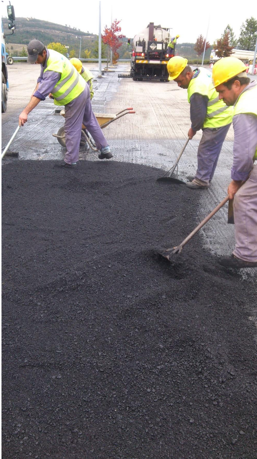
Figura 29 - Colocação de tapete betuminoso nos sítios onde a pavimentadora não pode
