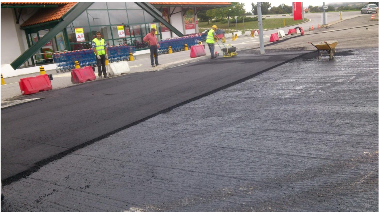
Figura 31 - Pré resultado, antes da passagem dos cilindros
