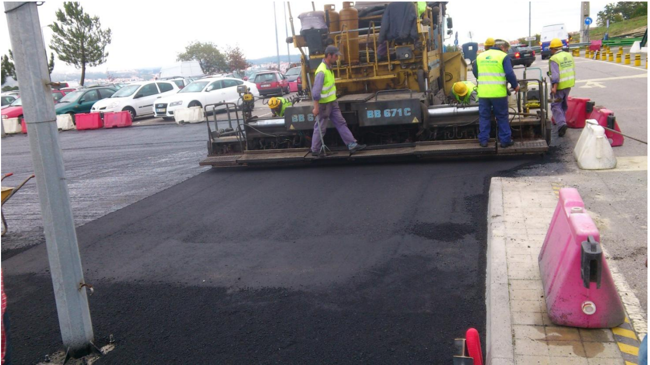
Figura 30 - Pavimentação com a pavimentadora
