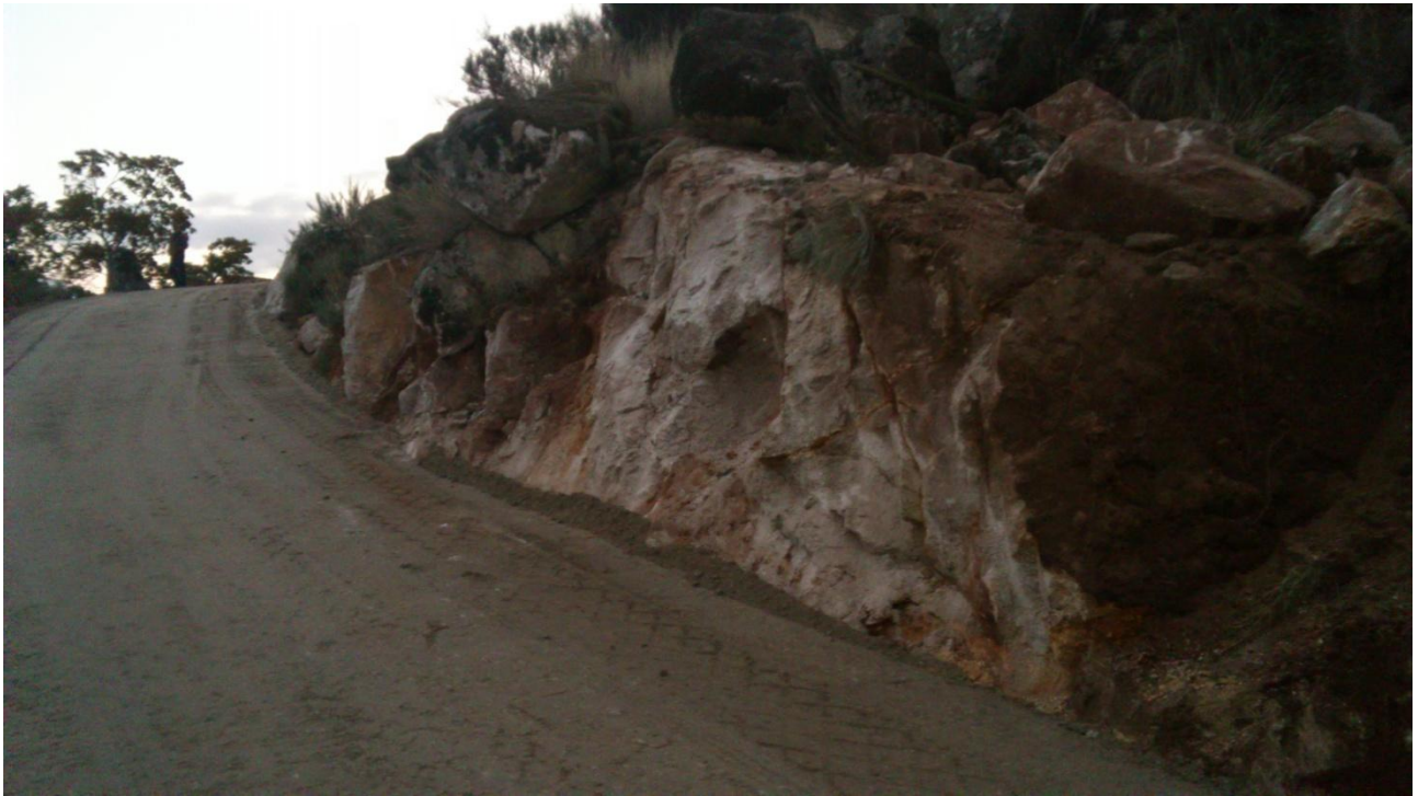
Figura 23 - Camada de base compactado e pronto a receber rega de impregnação e camada de regularização (tapete betuminoso)
