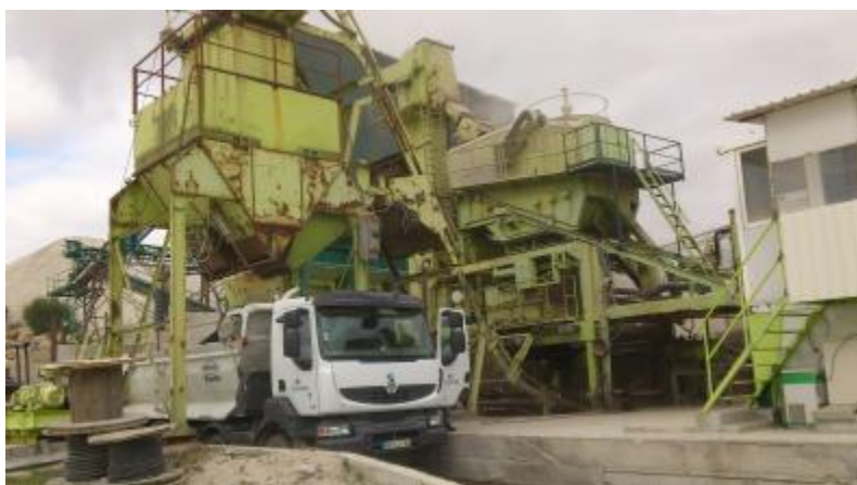
Figura 5 – Central de Betuminoso
