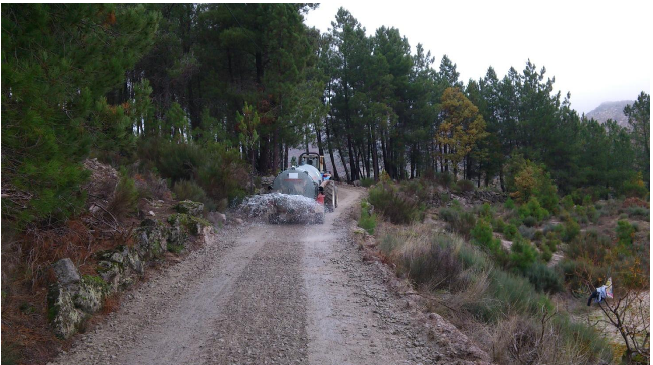
Figura 22 - Aplicação de toutvenant de modo a ficar ligeiramente colocado, regar para uma melhor compactação para posteriormente se compactar
