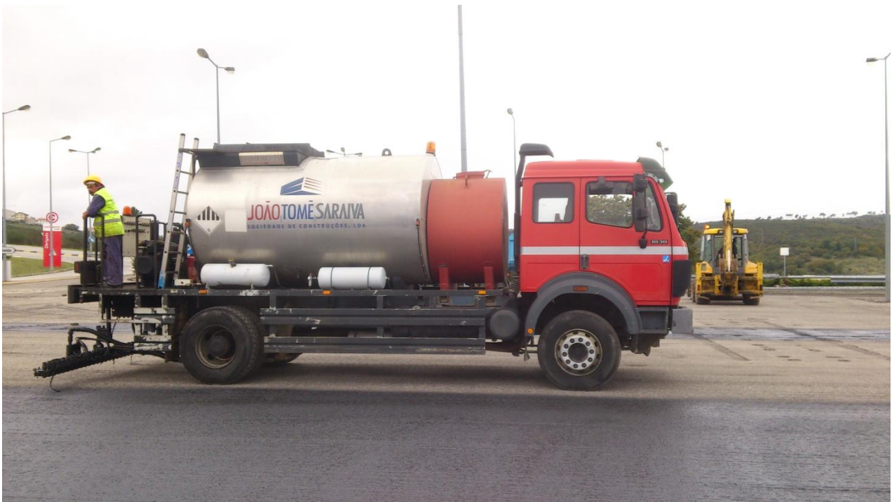
Figura 24 - Equipamento – Camião de rega asfáltica
