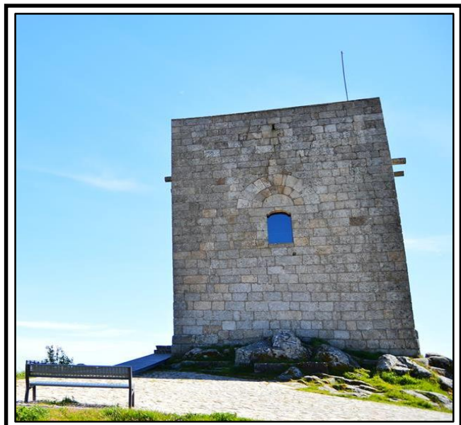
Figura 35 – Torre de Menagem
