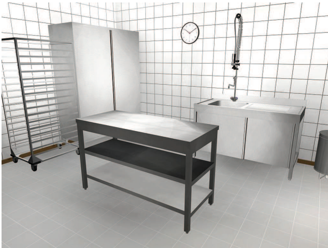
Figura 12 – Vista da zona de lavagem e armazenamento de louças
