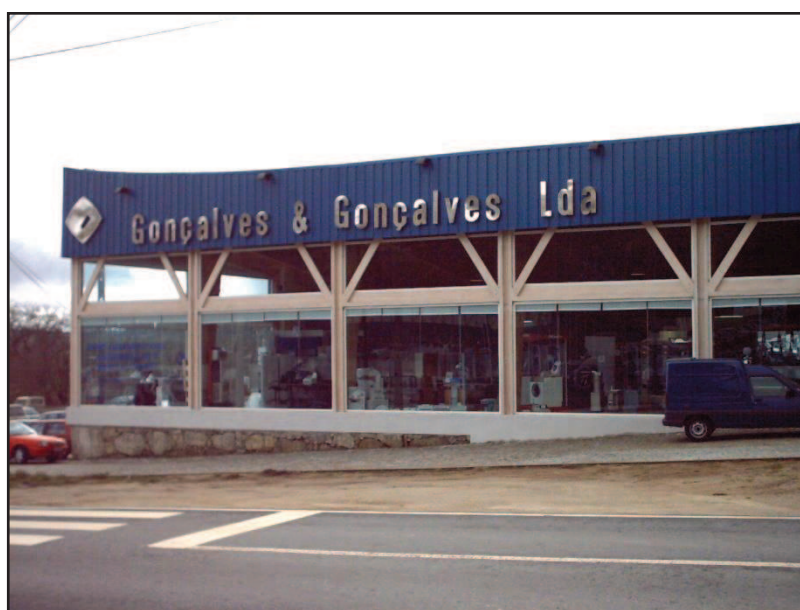
Figura 1- Instalações da Gonçalves & Gonçalves, Lda
