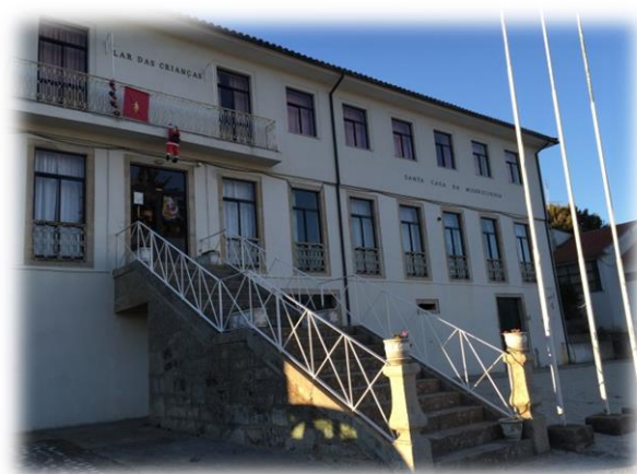
Imagem 3: Edifício do Lar de Acolhimento
