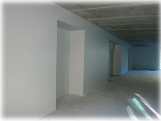
Figura 20. Fotografia da Parede do Refeitório da Movecho SA
