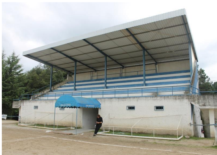
Figura 5 - Complexo Desportivo de St. Eufémia (bancada)
