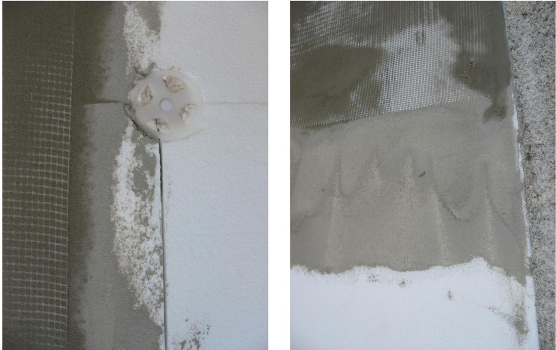
Figura 26 – Colocação da armadura
