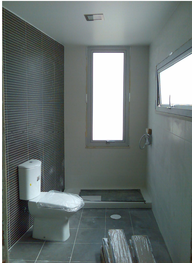
Figura 15 . Interior – W.C., Moradia de Coimbra.
