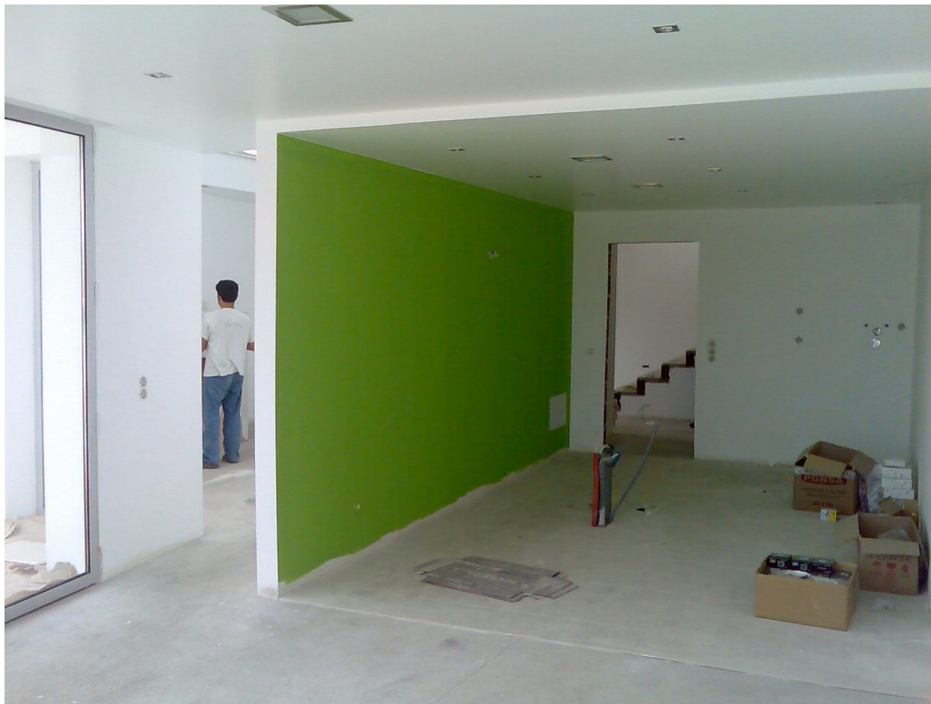
Figura 13 . Interior - Cozinha, Moradia de Coimbra.
