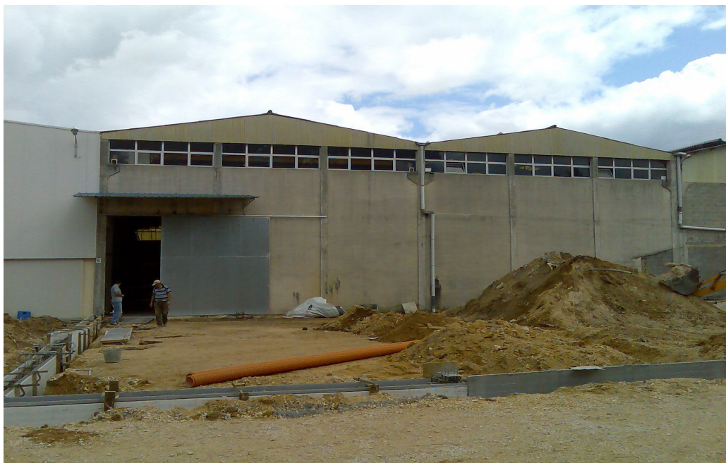
Figura 7 . Construção do novo Pavilhão, Metalfer.
