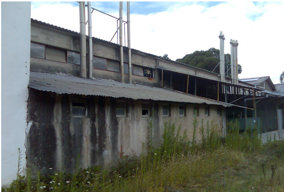
Figura 3 . Parte de alçado lateral esquerdo existente, Metalfer.
