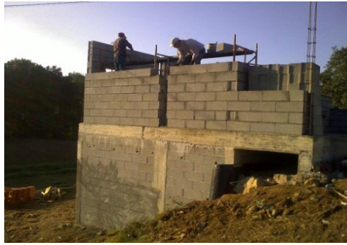
Figura n.º 10 - Descofragem e aplicação de blocos.
