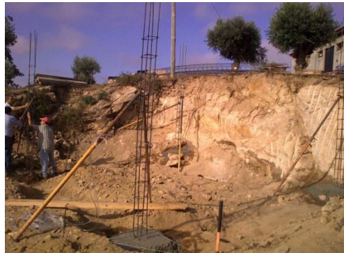
Figura n.º 3 – Betonagem das sapatas.
