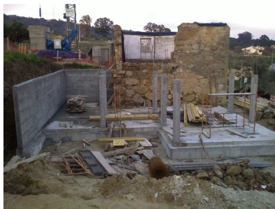
Figura n.º 20 - Descofragem dos muros e dos pilares.
