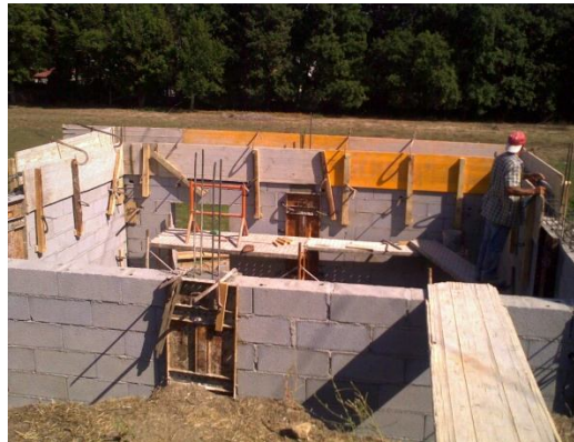
Figura n.º 6 – Cofragem dos pilares e vigas do lintel.
