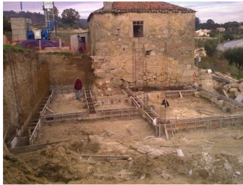
Figura n.º 14 – Cofragem das vigas de fundação.
