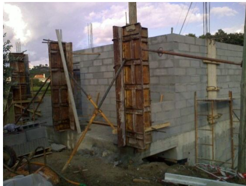
Figura n.º 11 - Cofragem dos pilares e vigas do lintel.
