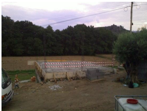
Figura n.º 9 - Betonagem da primeira laje.
