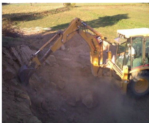
Figura n.º 2 - Limpeza do terreno e escavação para construção das sapatas da fundação;
