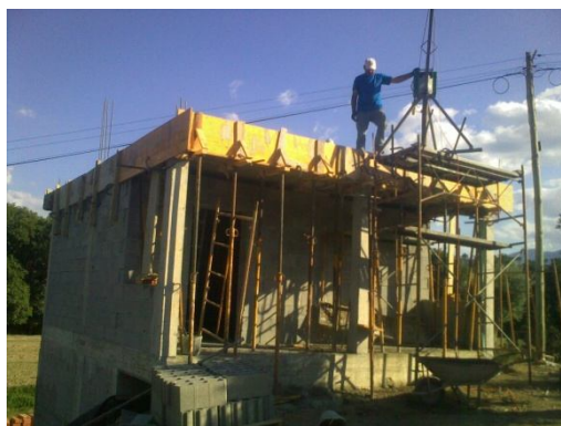
Figura n.º 12 - Aplicação das vigas pré-esforçadas e abobadilhas, assim como betonagem da segunda laje.
