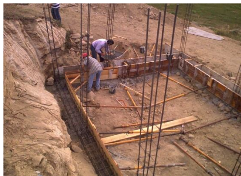
Figura n.º 4 - Armaduras de vigas de fundação, cofragem e betonagem.
