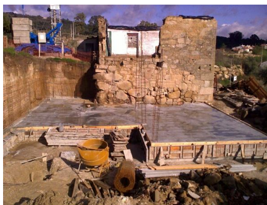
Figura n.º 17 - Betonagem da primeira laje.
