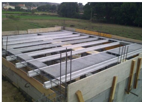
Figura n.º 8 - Aplicação das vigas pré-esforçadas e abobadilhas.
