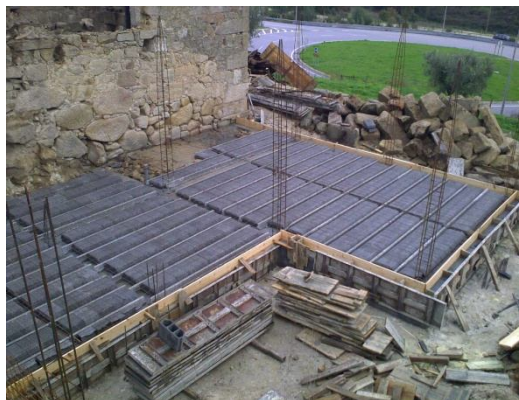
Figura n.º 16 - Aplicação das vigas pré-esforçadas e abobadilhas.
