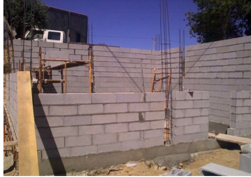
Figura n.º 5 - Descofragem das vigas de fundação e assentamento de blocos.
