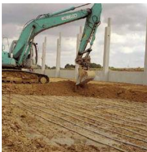
Figura 42. Enchimento com solo [16]
