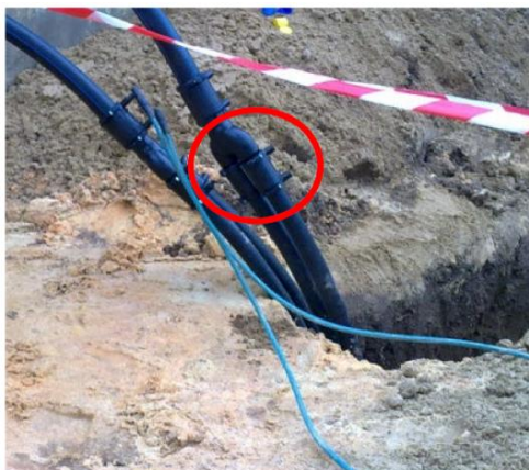
Figura 36. União aos coletores de distribuição [16]
