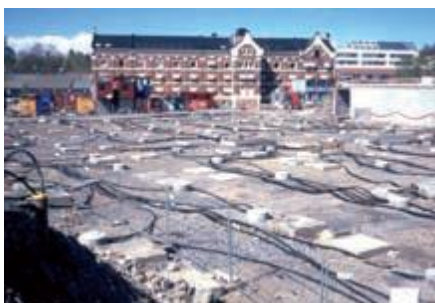
Figura 6. Campo de circuitos verticais em Nydalen [7]
