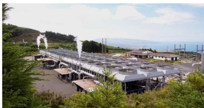
Figura 10. Central geotérmica da Ribeira Grande [9]
