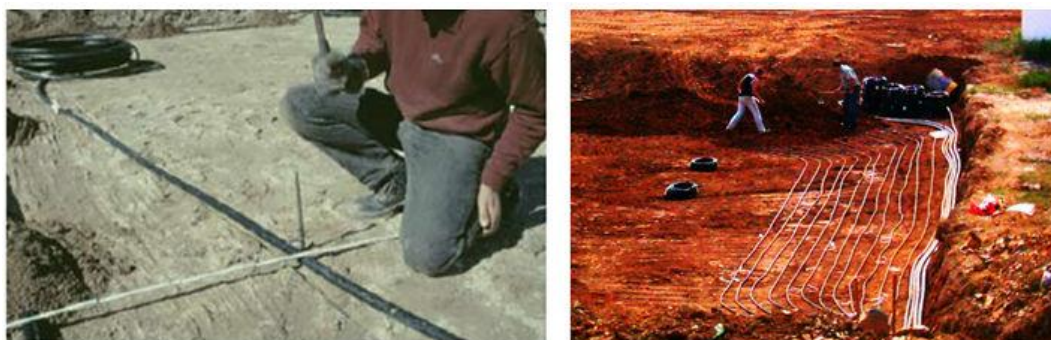
Figura 40. Estacas e alinhamento [16]
