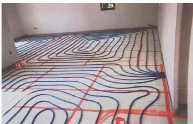
Figura 23. Circuito de tubagem de piso radiante [16]
