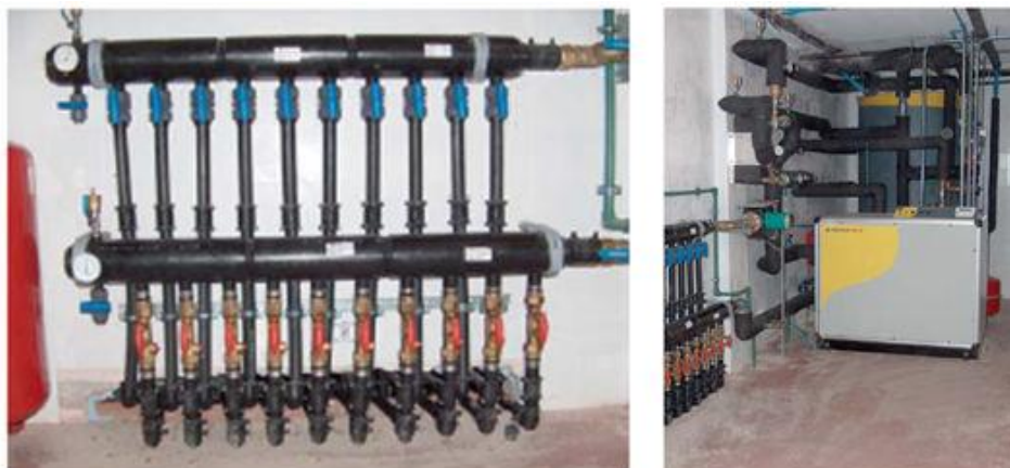
Figura 37. Coletores de distribuição [16]
