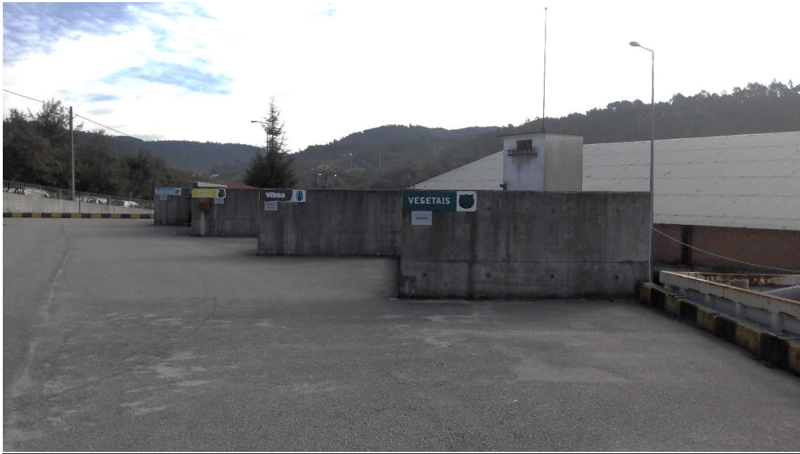
Figura 23 – Locais de deposição no Ecocentro de São Pedro do Sul
