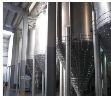
Figura nº 13 - Silos de PVC
