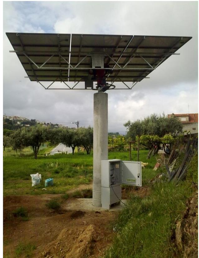
Montagem da estrutura de um seguidor de painéis foto voltaicos para uma micro produção.
