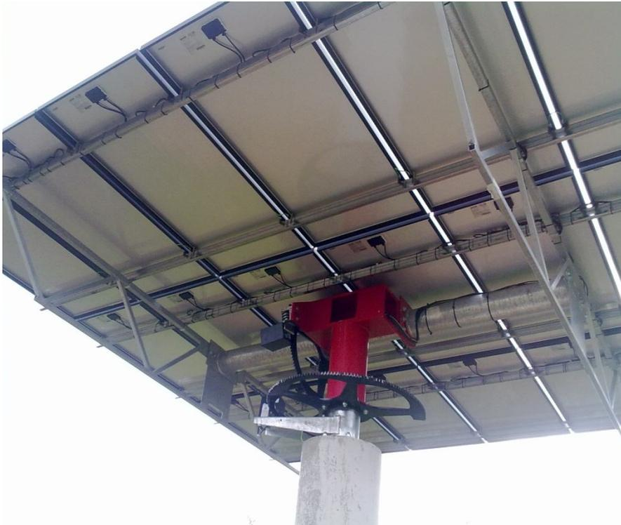
O bloco é um engenho mecanizado, que com a ajuda de um ou dois motores (dependendo das características do seguidor), fás a rotação e orientação de toda a estrutura para um melhor aproveitamento da energia solar possível.
