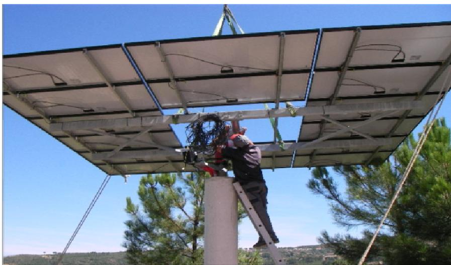
No final de aplicar os painéis na estrutura procede-se á colocação desta, com a ajuda de uma grua na extremidade do pilar.
