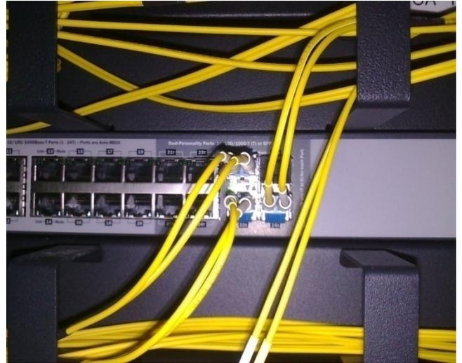
Dispositivo que faz a interligação dos cabos de fibra óptica dos diversos operadores, à rede de cabos de fibra óptica do edifício.
