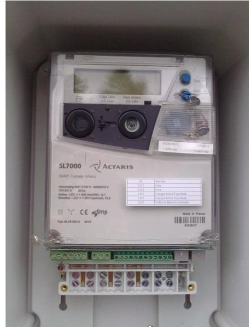
Este equipamento instalado destina-se á contagem da energia (kW/hora) injectada na rede produzida pelos painéis. Contém também um módulo que permite através de uma ligação telefónica sem fios a contagem á distância da produção.
