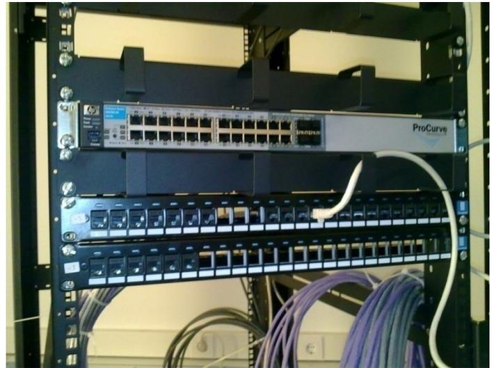
Funcionamento baseado na tecnologia de comutação de quadros Ethernet e Fast Ethernet em modo de funcionamento auto-sensing, com possibilidade de comutação store-and forward e cut-through. Segundo as normas 802.3 e 802.3u
