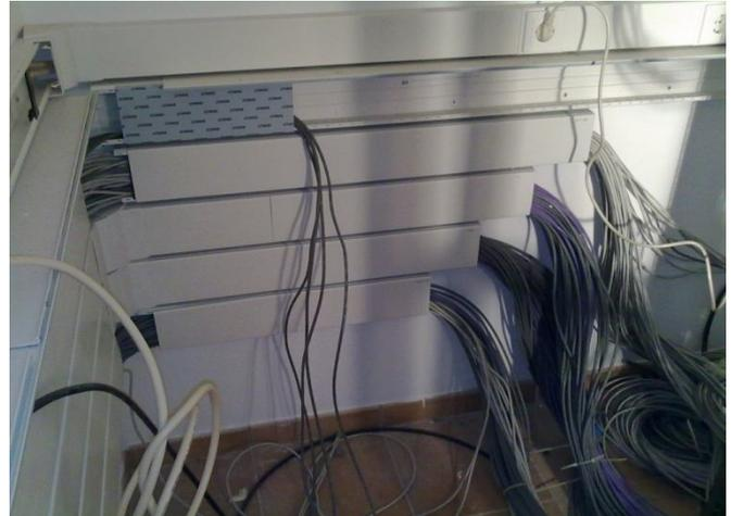
Os Caminhos de Cabos são constituídos por estruturas metálicas ou de plástico (Esteiras ou calhas), tipicamente de secção em „U“ (espaços abertos ou fechados), dedicados à passagem de cabos ao longo de paredes, tectos e pavimentos.
