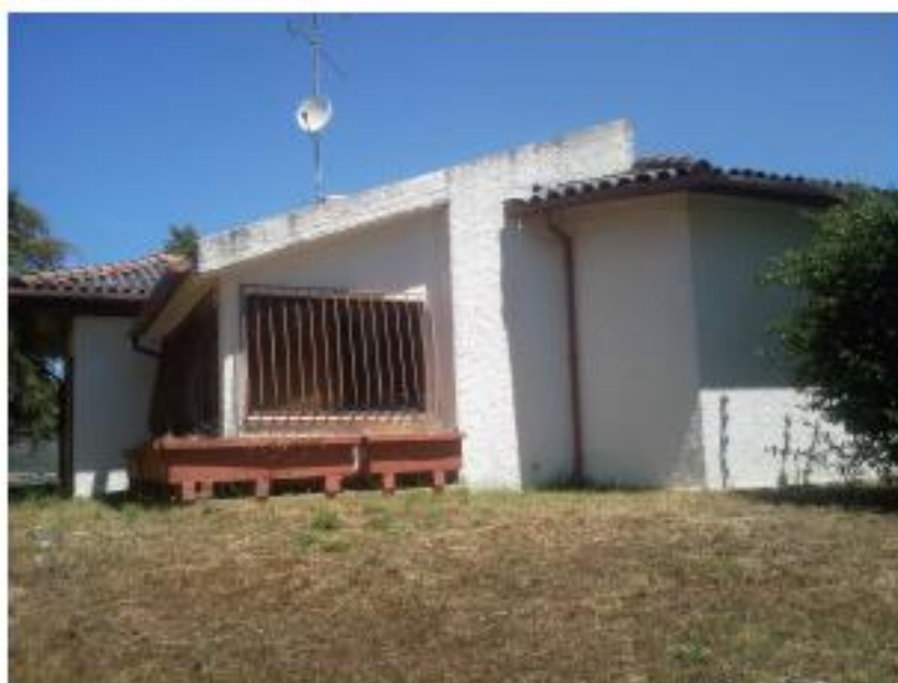
VISTA DO ALÇADO LATERAL ESQUERDO
