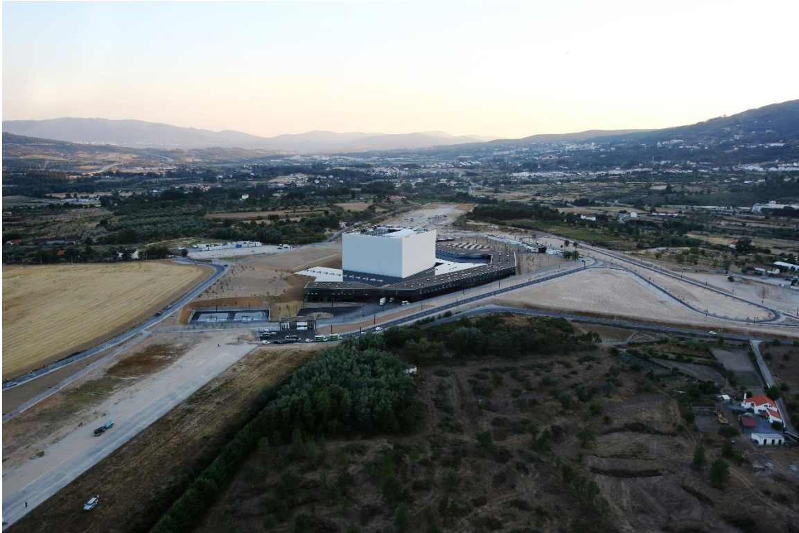
FIGURA 1 - VISTA AÉREA DO DATA CENTER – PT DA COVILHÃ, FONTE (PT, 2016)
