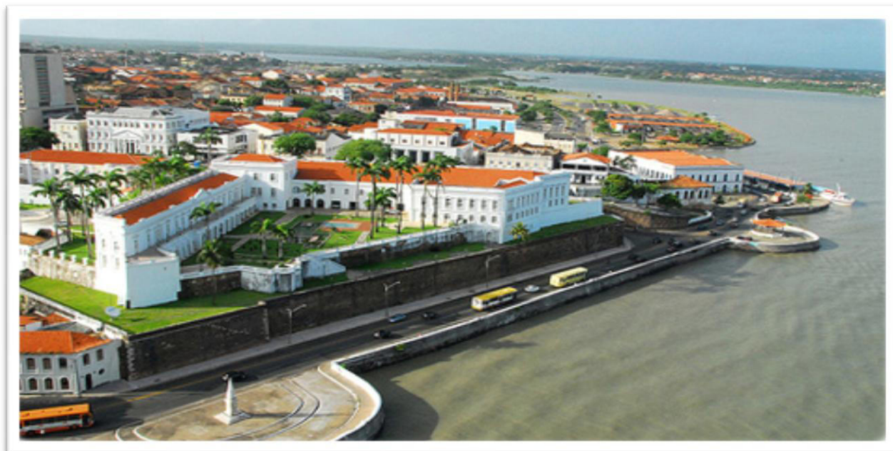
Figura 1 – Vista aérea do centro histórico de São Luís
