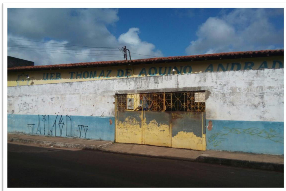
Figura 4 - Fachada da UEB Thomaz de Aquino Andrade
