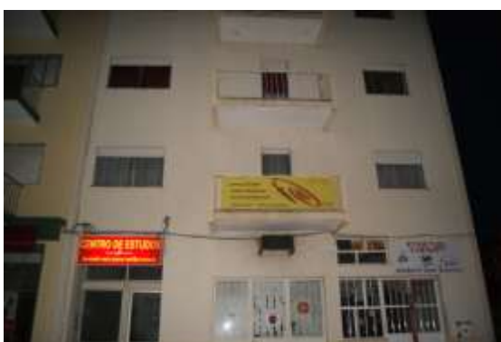
Fig.2 – Prédio (fonte própria)
