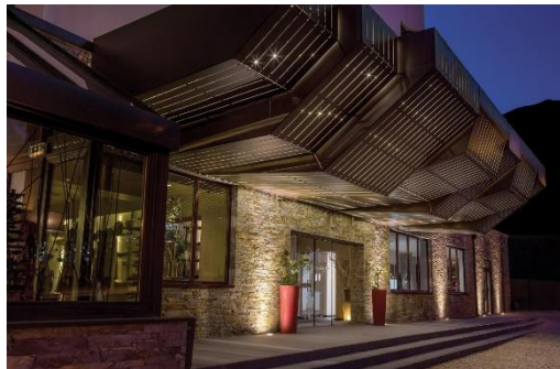
Figura 8 Fachada do Hotel
