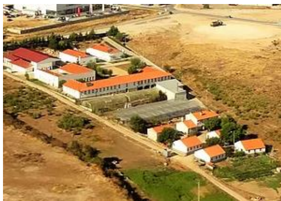
Figura 2- Edifício Sede. Quinta Pedagógica Fonte: https://goo.gl/images/hJXiGH
