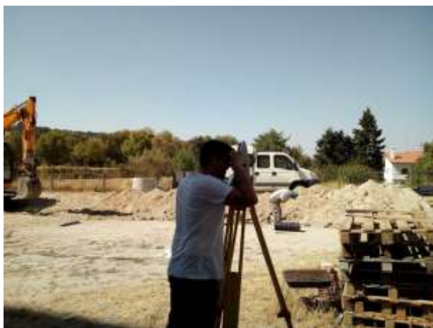
Fig. 67 Foto do estagiário a trabalhar com a Estação Total (fonte própria)
