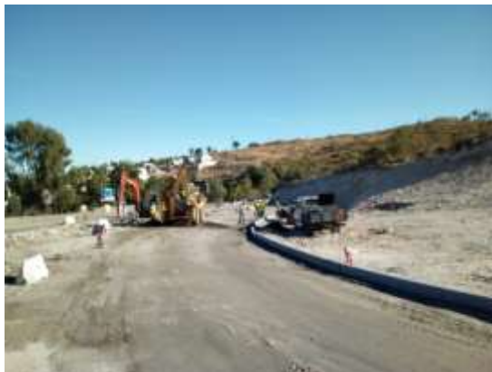
Fig. 61 Foto do local de trabalho com o terreno pronto para a implantação
