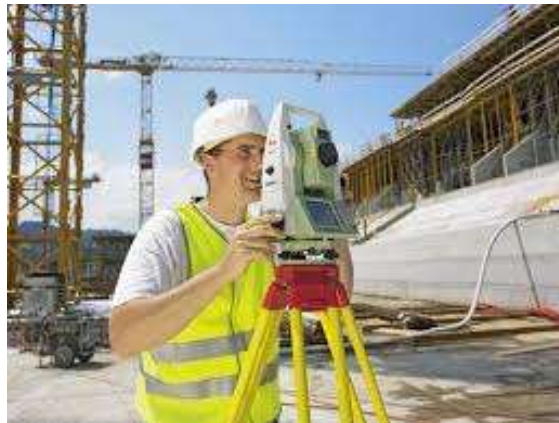
Fig. 1 Exemplo de recolha de dados em campo com estação total
