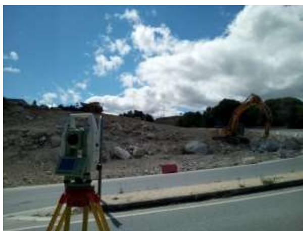
Fig. 57 Foto da área de corte e escavação (fonte própria)
