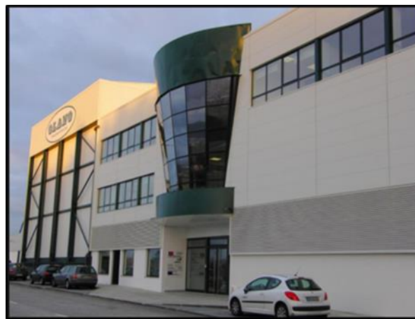
Figura 14-Sede Olano Portugal Transportes
