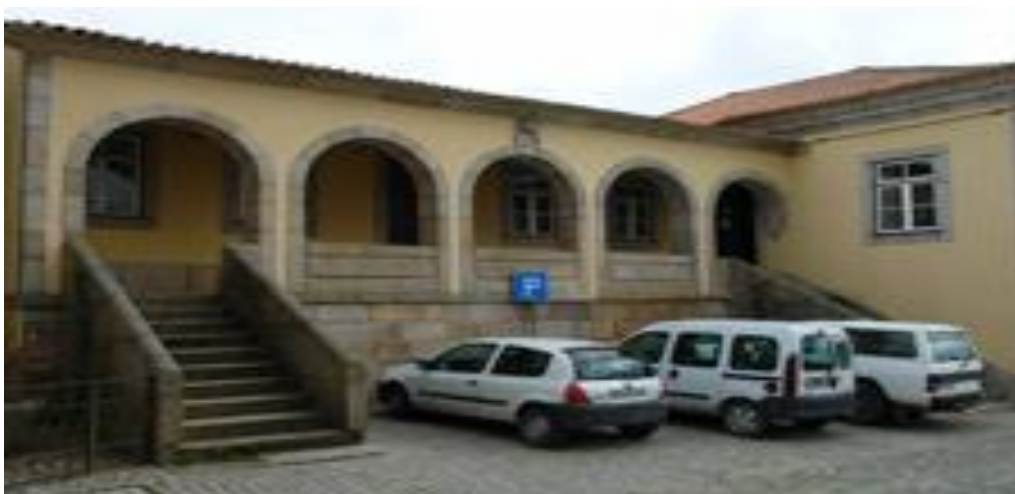
Figura 6: Edifício dos Serviços Técnicos da CMA
