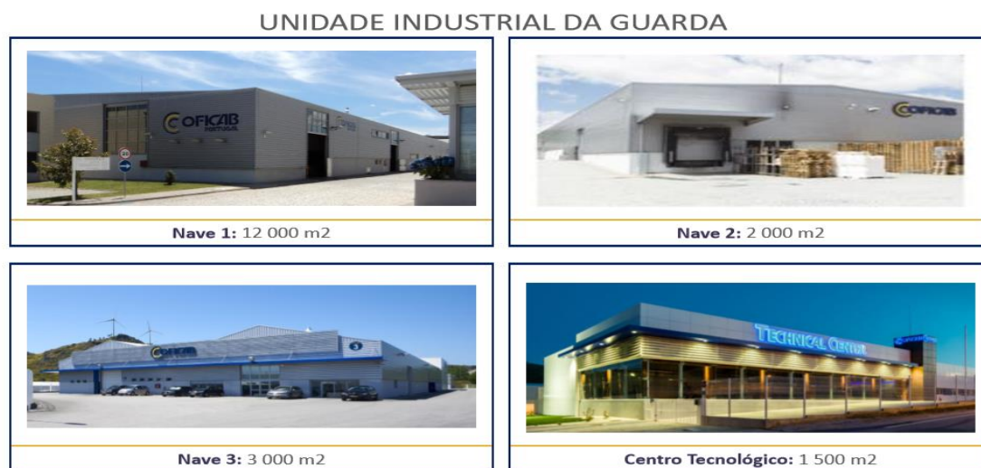
Figura 11 - Instalações da COF PT
