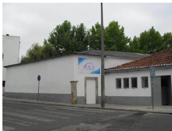
Imagem 9: Pavilhão da ACG (fonte própria)
