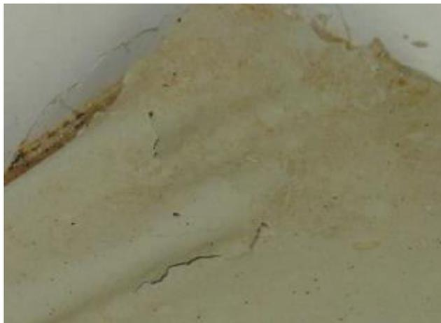
*Figura 25 – Empolamento de um pavimento epóxi [13]*
