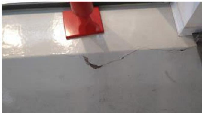
*Figura 24 – Descolamento de um pavimento epóxi*
