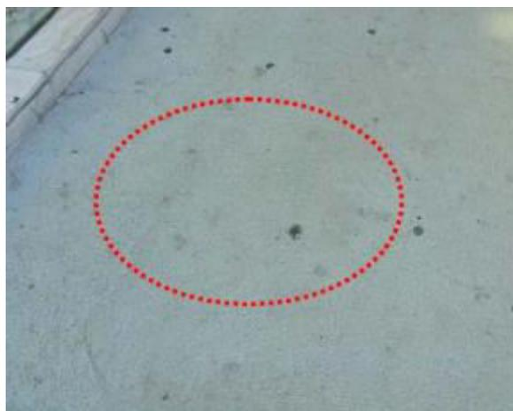
*Figura 32 – Perda de tonalidade em um pavimento epóxi [16]*
