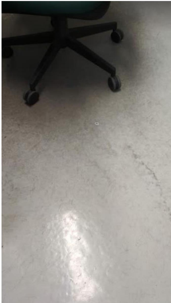
*Figura 28 – Desgaste em um pavimento epóxi*
