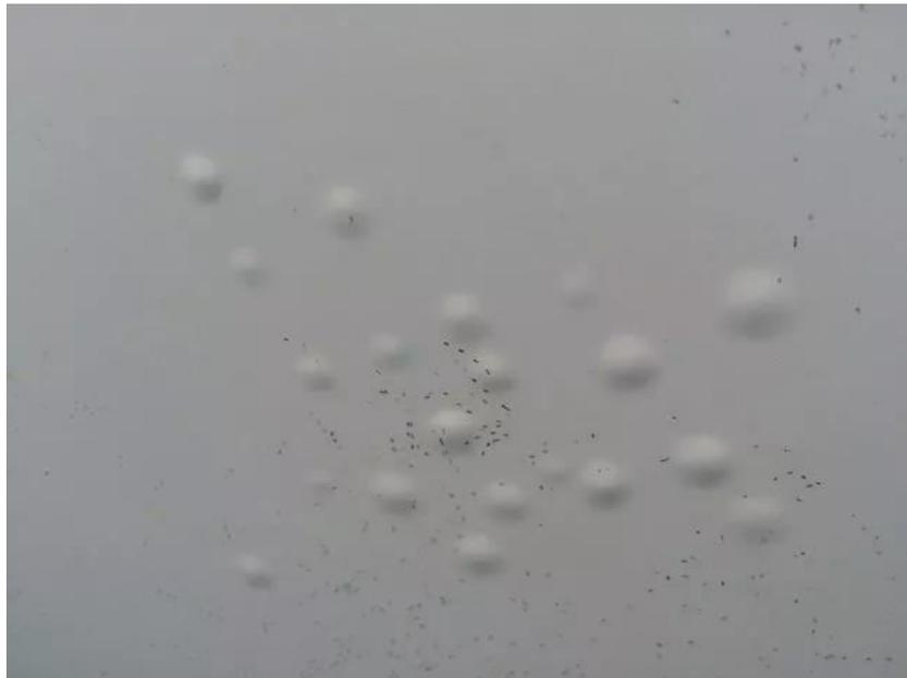
*Figura 30 – Bolhas osmóticas em um pavimento epóxi [15]*
