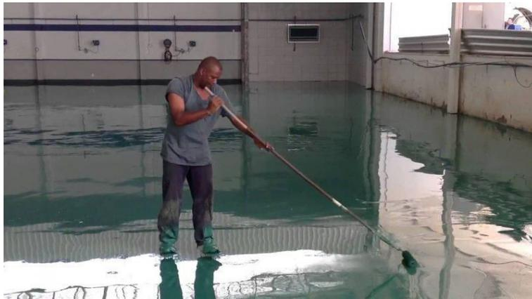
Figura 11 – Aplicação de um pavimento epóxi com um rolo [7]
