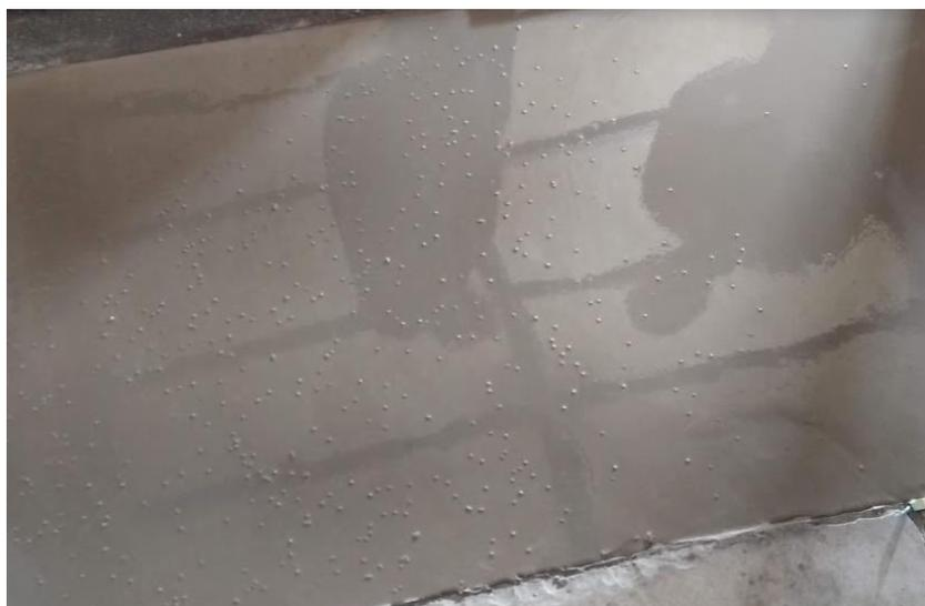
*Figura 31 – Bolhas de difusão de ar em um pavimento epóxi*
