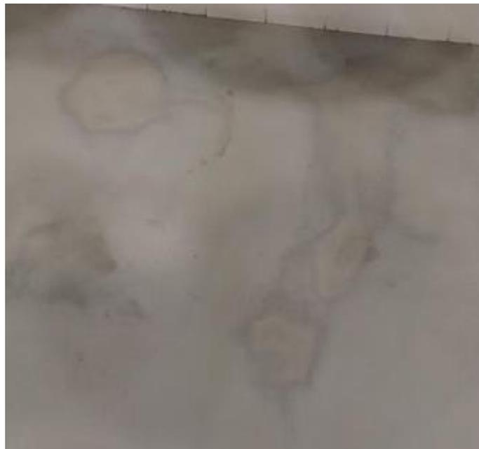
*Figura 27 – Manchas em um pavimento epóxi*
