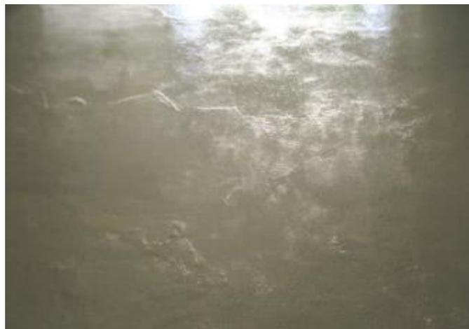
*Figura 29 – Falta de planimetria em um pavimento epóxi [14]*
