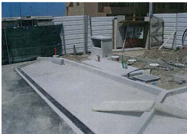
Fig.26 – Canal zona de ar e água
