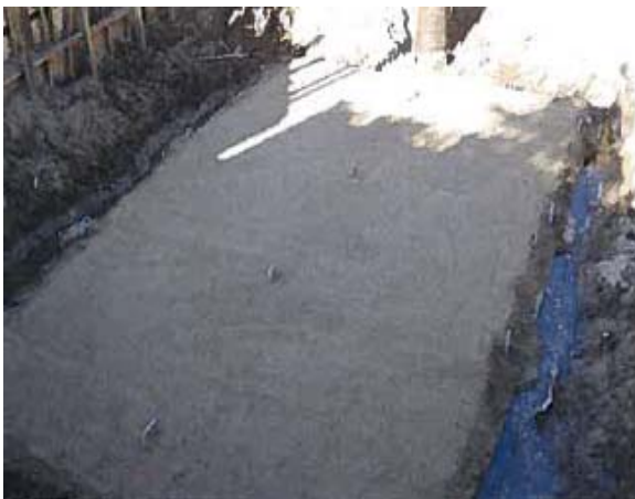
Fig 19 – Pormenor de laje
