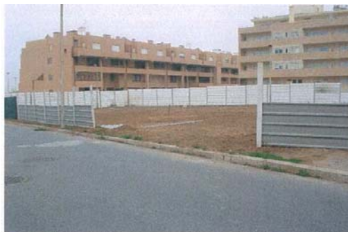
Fig. 16 – Vedação da área de intervenção
