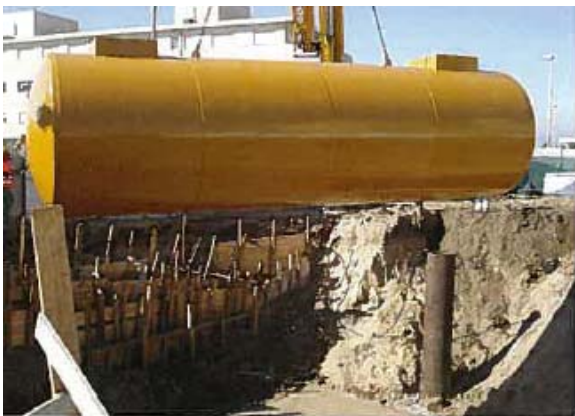
Fig. 21 – Colocação de tanque
