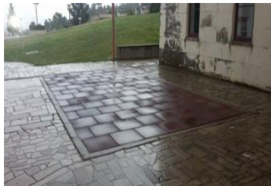
FIGURA 10- ZONA OUTDOOR (FONTE PRÓPRIA)
