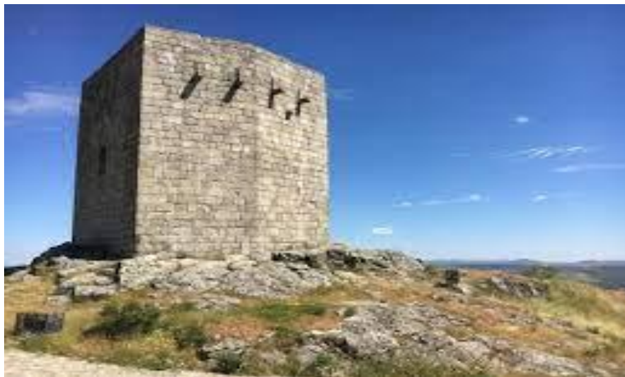
Figura 2- Torre de Menagem
