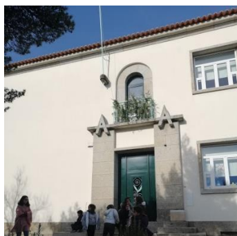
Figura 25 - Fachada principal do edifício Fonte: Elaboração Própria
