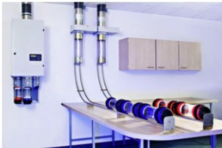
*Figura 38-Sistema de transporte Pneumático*
