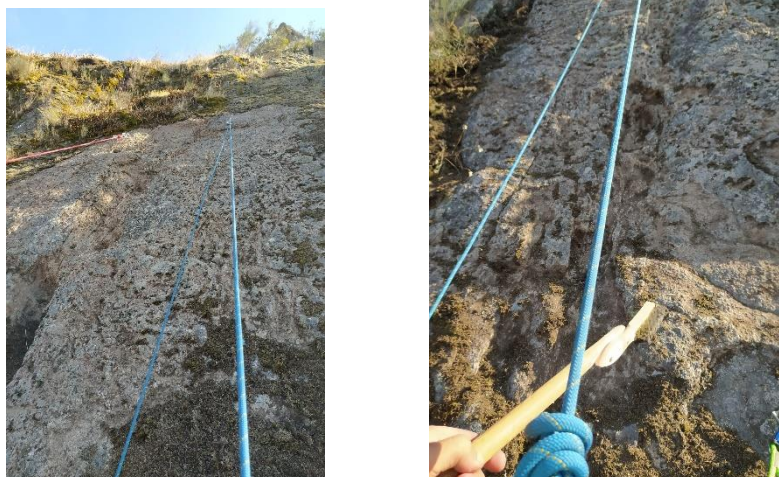
Figura 18- Limpeza de uma parede
