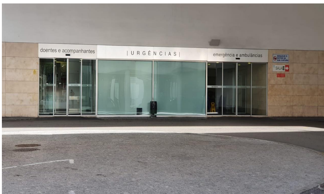
Figura 3- Serviço de Urgência Médico Cirúrgico do Hospital Da Guarda
