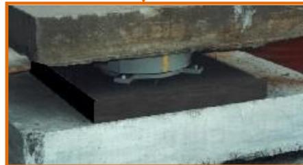
Imagem39- Aparelho de apoio colocado
