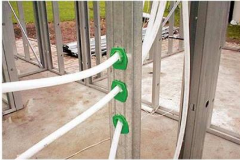
Figura 3.51: Instalação de fixadores especiais para as tubulações. Fonte: Battistella (2011).
