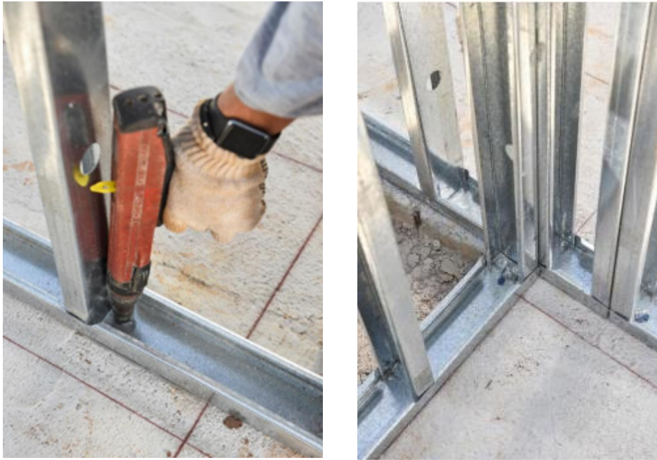
Figura 3.10: Fixação de painéis. Fonte: Santiago et al. (2012).
