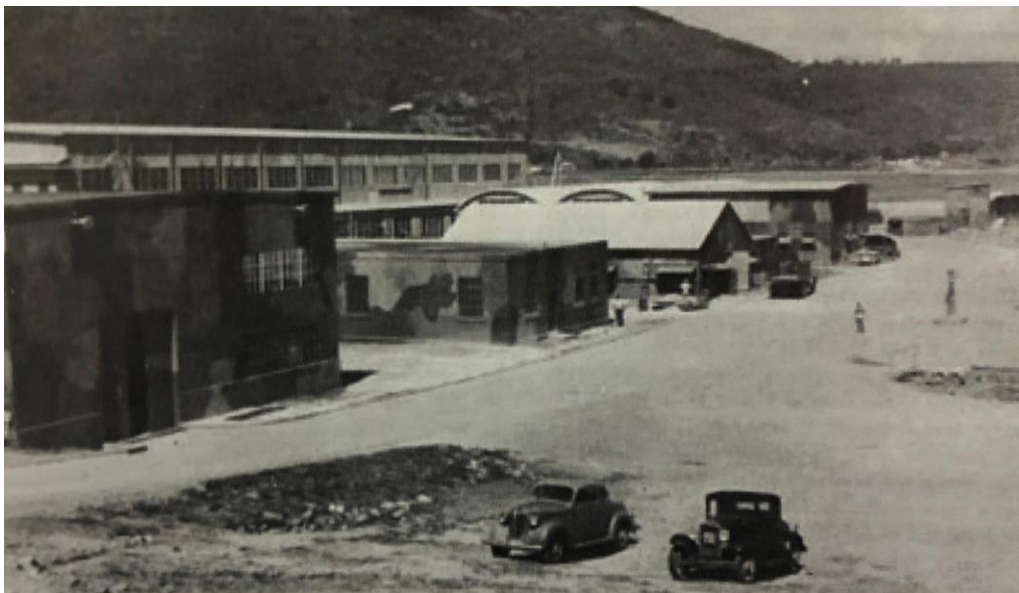
Figura 2.2: Construções em L.S.F., campo Bourne em Saint Thomas Island. Fonte: Department of the Navy (2022).
