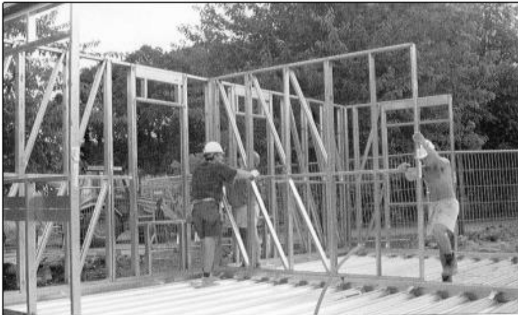
Figura 2.8: Posicionamento do painel em obra. Fonte: Grubb et al. (2001).
