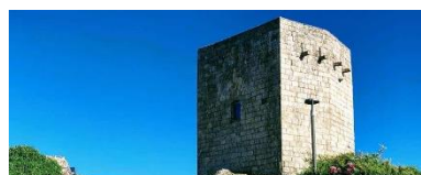
Figura 4 - Torre de Menagem
